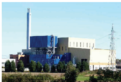
L'impianto di termoutilizzazione di Piacenza
